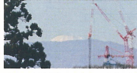
上の道路からの眺め (右の重機はリニア新幹線の掘削工事)
